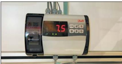
Этот блок специально предназначен для управления работой компрессорно-конденсаторных агрегатов OPTUMA™ и для блочных компрессорно-конденсаторных аг-
